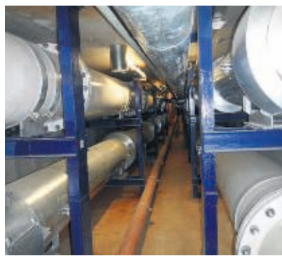
I anslutning till årsrevisionen 2012 vid Lovisa 1 förnyades en stor del av mellankylsystemet. Förnyandet gällde cirka 810 meter rör.
